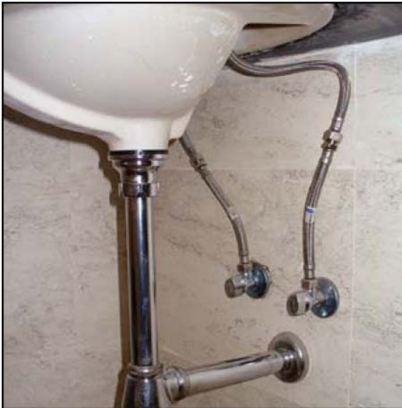
Figura CH-4. Conectores flexibles
