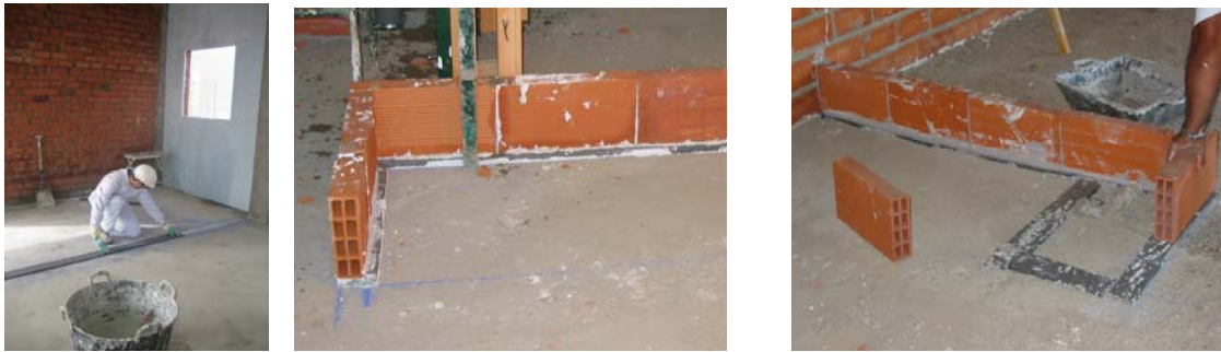
Detalle del replanteo y ejecución de particiones con bandas elásticas
