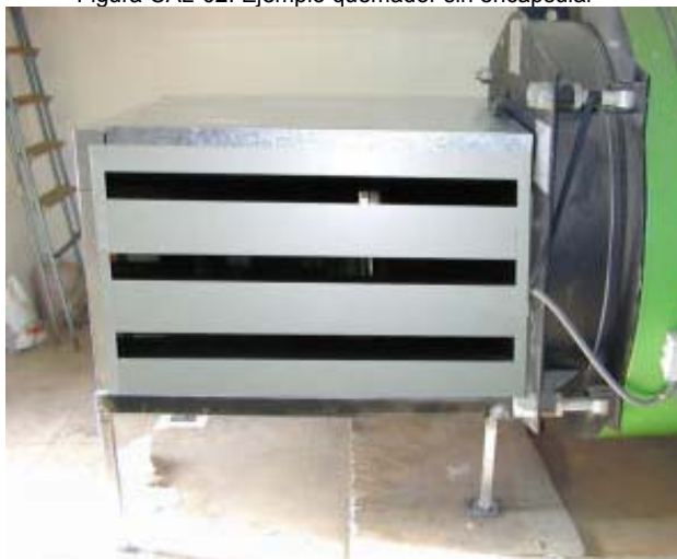
Figura CAL-03. Ejemplo quemador con encapsulado y silenciador para la ventilación del quemador.
