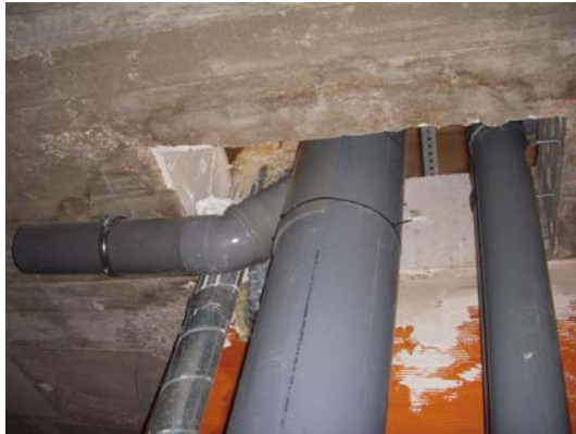
Figura CP-11. Ejemplo de anclaje de conductos de ventilación y de bajantes
