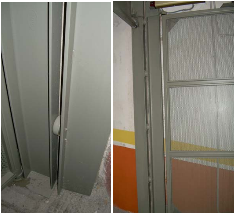
Figura PG-02 Ejemplo de colocación de amortiguadores sobre estructura de la puerta
