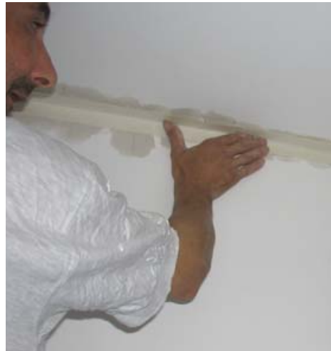
Detalle ESV-02.a.R3. Remate de la junta
