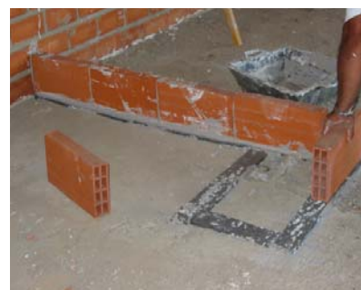
Detalle del replanteo y ejecución de particiones con bandas
