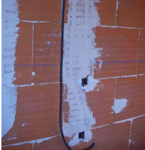
Figura CH-1. Detalle rozas retacadas
