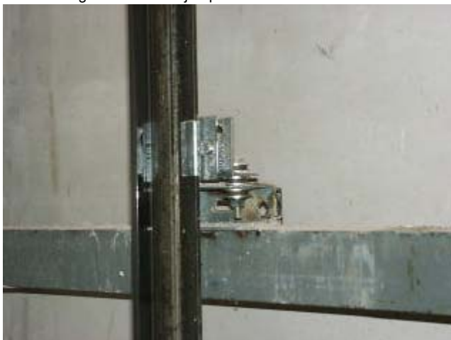
Figura ASC-04. ejemplo de anclaje de guías
