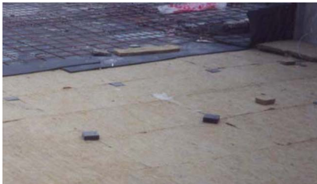
Figura R_INST-02. Ejemplo de un suelo flotante
