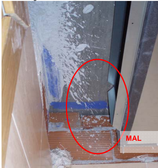
Figura CH-2. Detalle encuentro forjado partición
