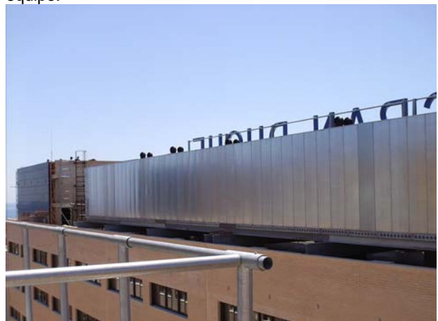
Figura 04. Detalle de la instalación de pantalla
