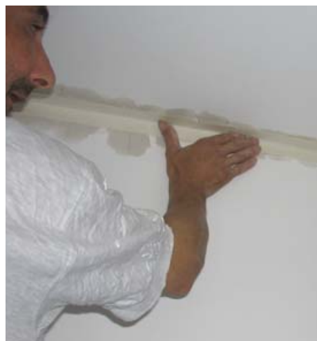
Detalle ESV-02.b.R3. Remate de la junta
