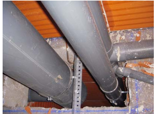
Figura CP-11. Ejemplo de anclaje de conductos de ventilación y de bajantes
