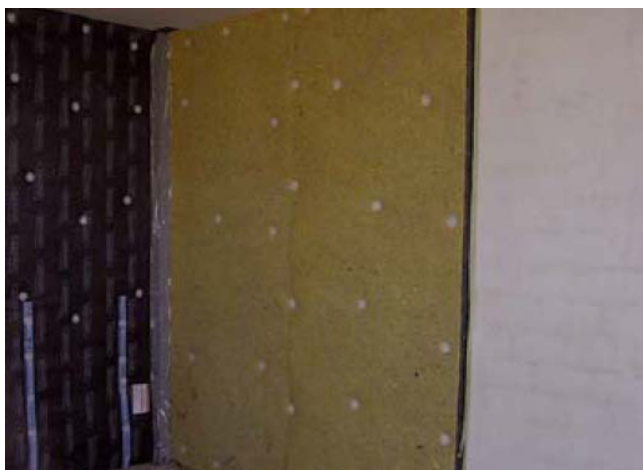
Figura R_INST-05. Ejemplo de un trasdosado
