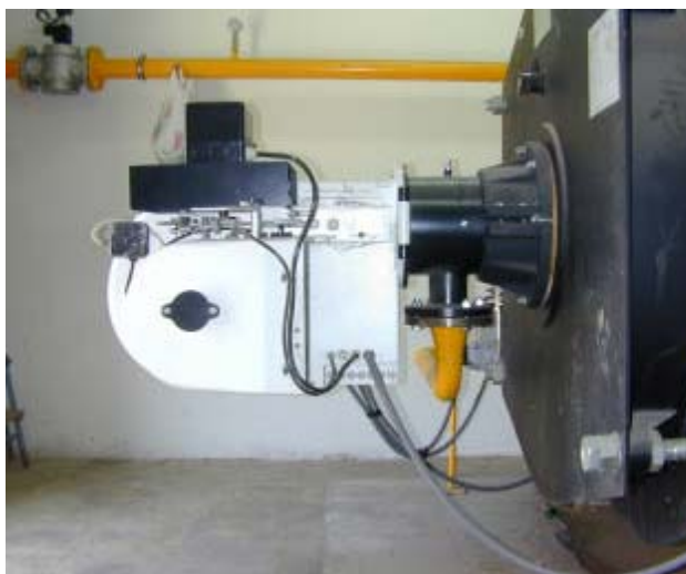
Figura CAL-02. Ejemplo quemador sin encapsular
