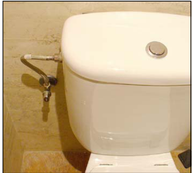
Figura CH-5. Conectores flexibles y junta elástica desolidarizadora
