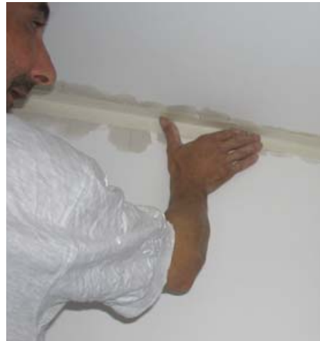
Detalle ESV-02.c.R3. Remate de la junta
