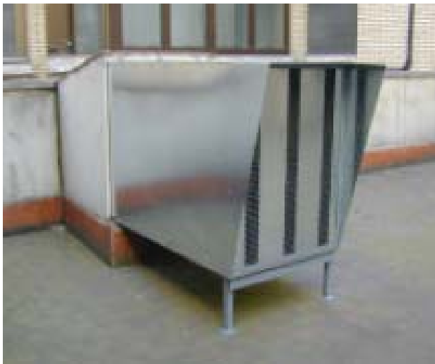
Figura CAL-06. Ejemplo de un silenciador
