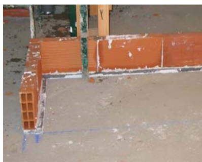
Detalle del replanteo y ejecución de particiones con bandas
